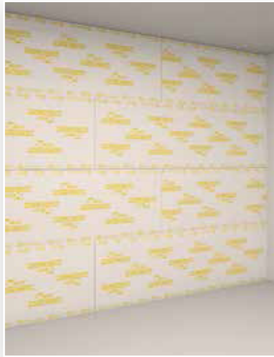
2._ plāksnes uzstādās līmeniski
